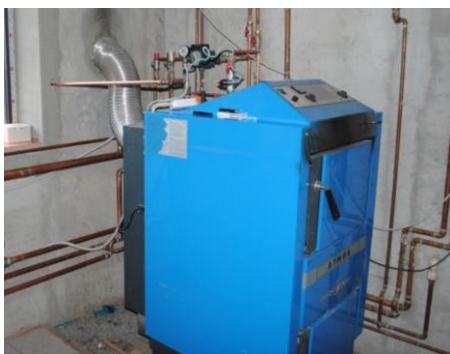
Figura 11. Centrala termica pe combustibil lemnos in stare de functionare
