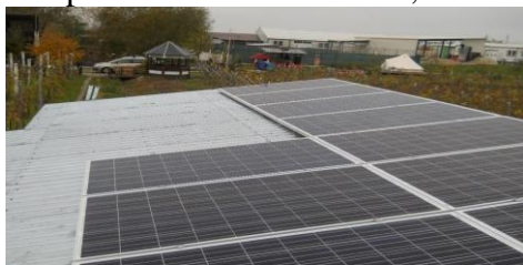
Figura 7. Amplasare panouri fotovoltaice pe acoperis
