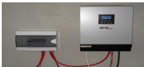
Figura 9. Modul de instalare sistem controler incarcare - invertor
