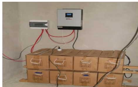
Figura 10. Modul de amplasare a acumulatorilor cu gel model Westech SG-200-12 200Ah / 12V
