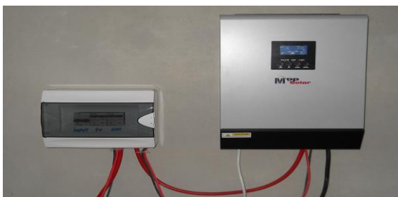
Figura 9. Modul de instalare sistem controler încărcare - inverter
