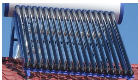
Figura 14. Instalare si amplasament panou termosolar
