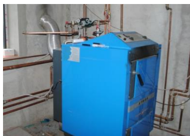
Figura 11. Centrala termica pe combustibil lemnos in stare de functionare
