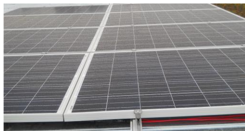
Figura 8. Montare panouri fotovoltaice pe sisteme fixe de poziționare
